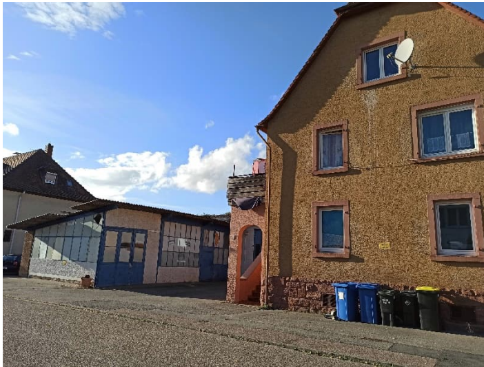
Abb. 2: Bestandssituation Brühlstraße 4 (Quelle: IFK)
