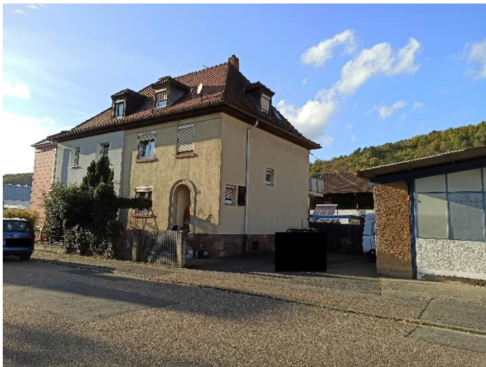
Abb. 3: Angrenzendes Wohngebäude Brühlstraße 6+8 (Quelle: IFK)
