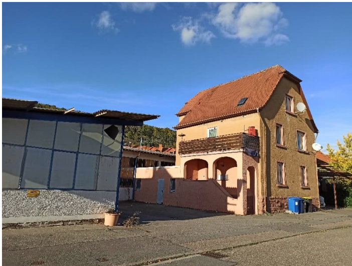
Abb. 4: Bestandssituation Brühlstraße 4 (Quelle: IFK)
